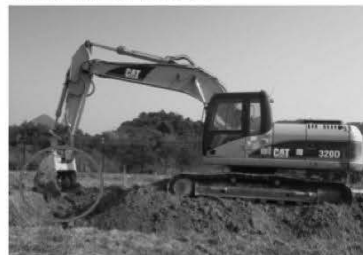
10月：大型機械によって1mの深さまで土を攪拌。赤丸で示したバケットの内部には攪拌装置が付随し、土をミキシングできる。
